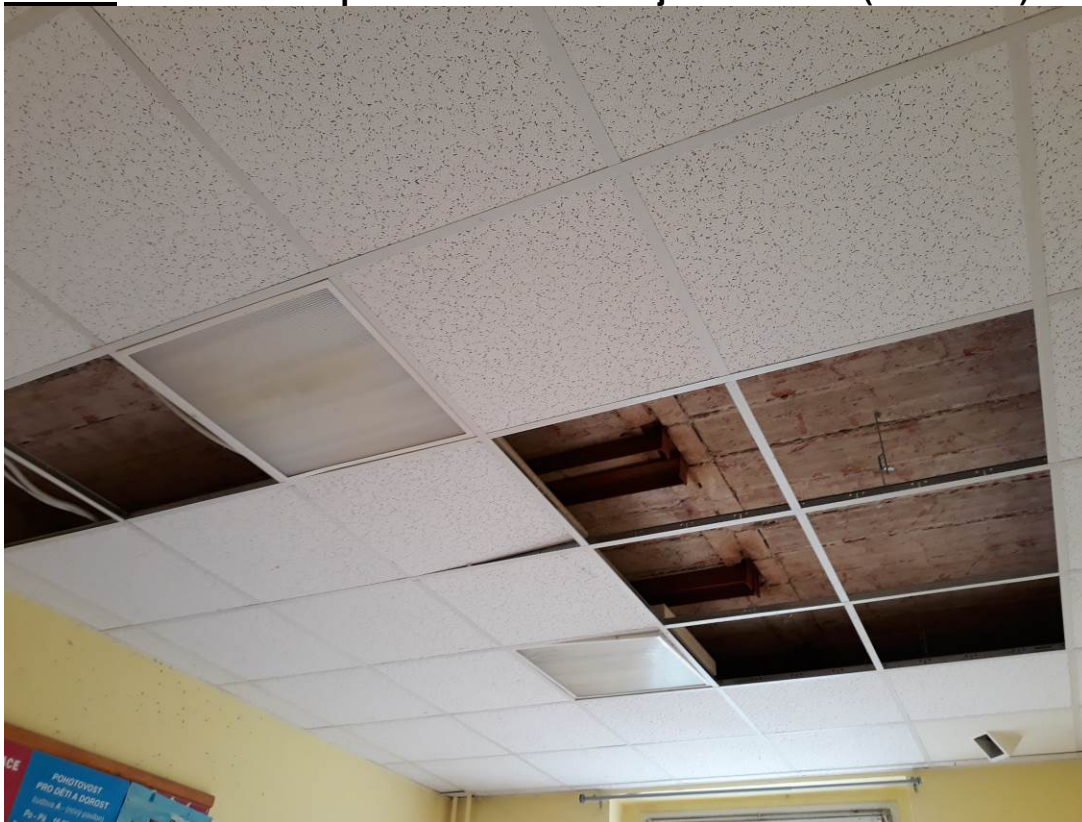
Obr.21: Sonda do stropní konstrukce 1.NP jižního křídla (I + Hurdís).
