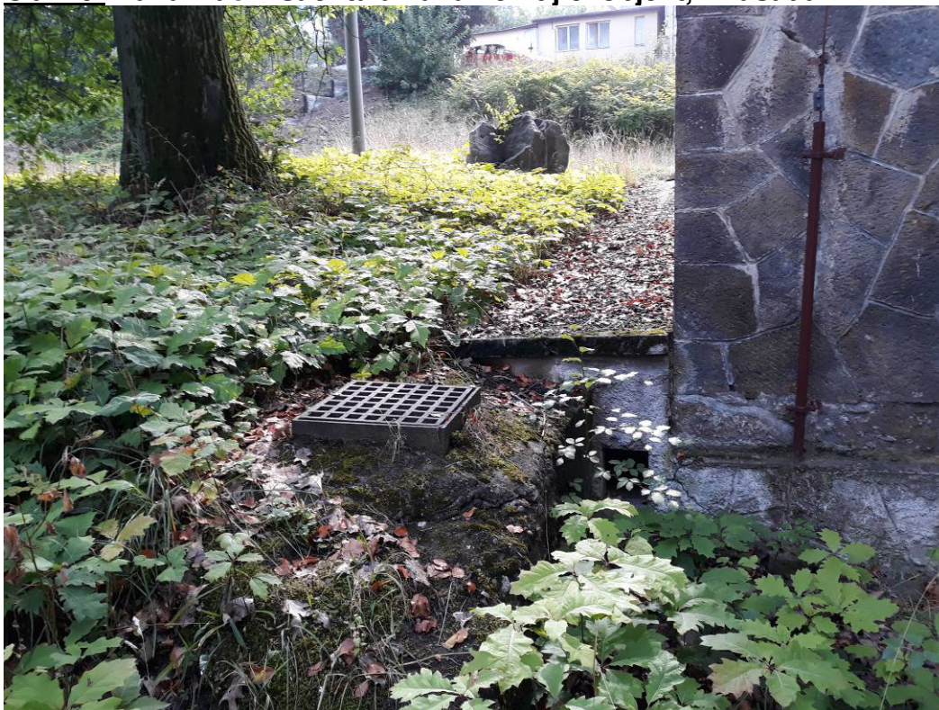
Obr.29: Kanalizační šachta a kanál lemující objekt, V fasáda.
