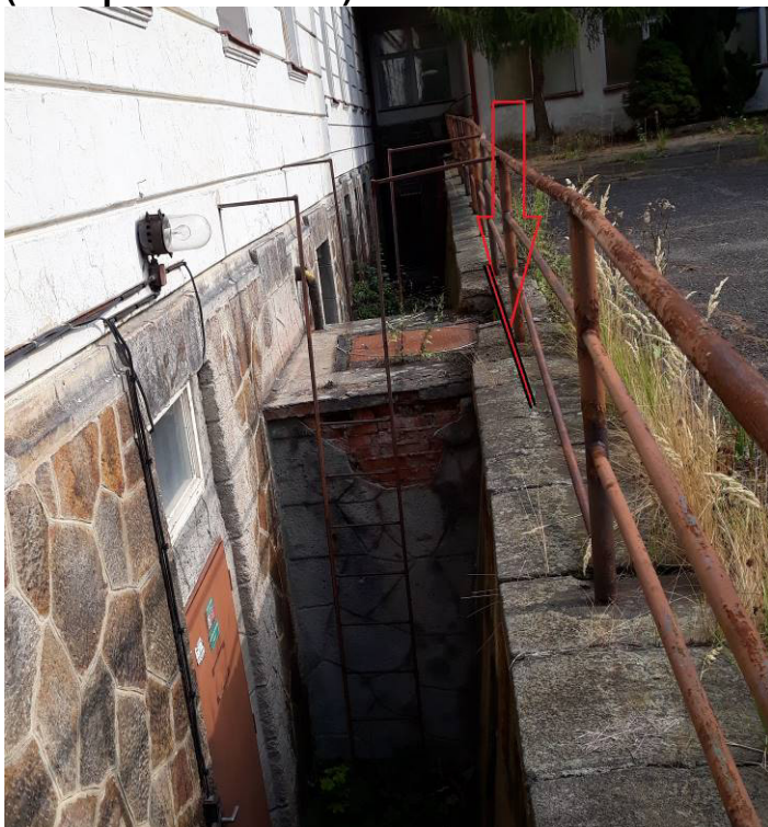
Obr.22: Vstup kolektoru do pavilonu M, šipkou vyznačena linie zabetonávky (zaslepení kolektoru).
