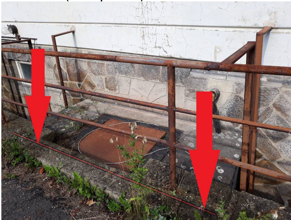
Obr.18: Pohled na vlez do kolektoru s vyznačením linie uzavření kolektoru betonovou zdí (v ose opěrné zdi).
